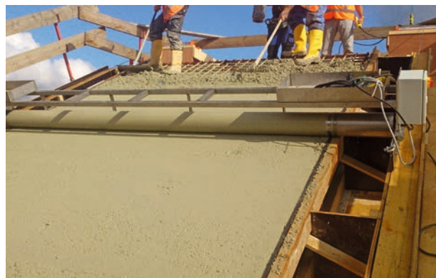
3 De bekisting is opgebouwd uit jukken
