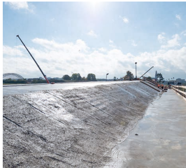
4 Helling van 27° in de dwarsdoorsnede van de Lentloper, foto: Thea van den Heuvel, DAPh
