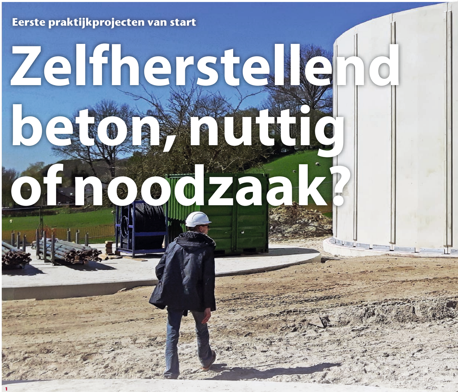
1 Tank WBL in opbouw
